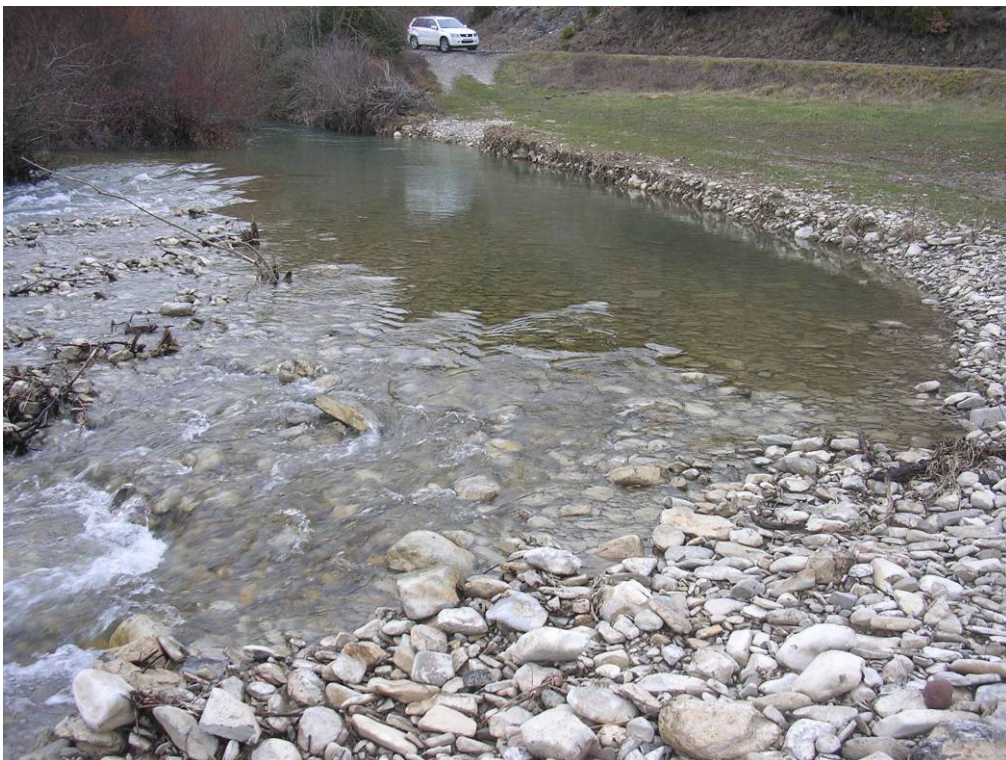
Foto 2: Foto donde se observa como la margen izquierda ha desaparecido
