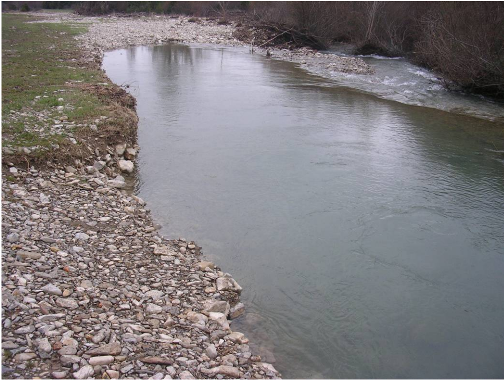
Foto 3: Vista del punto donde se pretende construir la defensa de escollera
