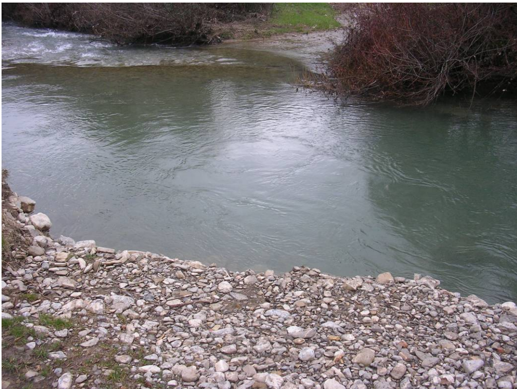
Foto 4: Punto en el que se pretende construir el paso del camino que da acceso a fincas de cultivo
